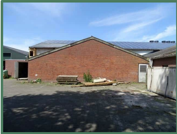
Te slopen stallen oostzijde plangebied
