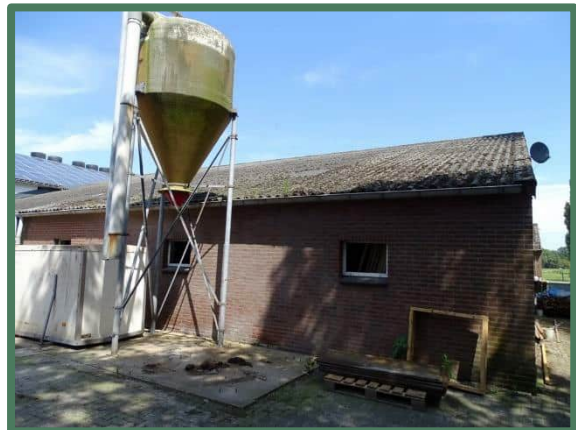
Te slopen stal oostzijde plangebied
