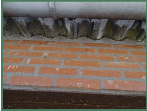
Vogelschroot onder dak
