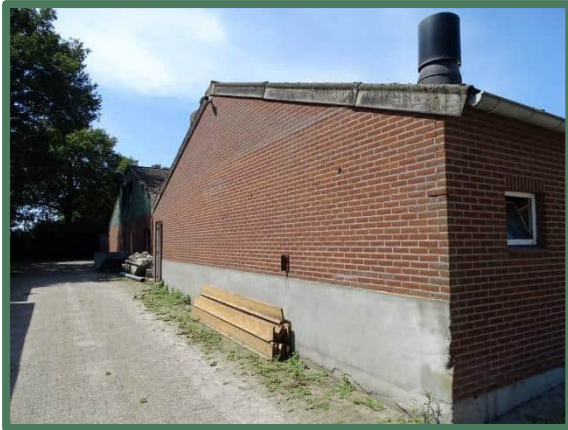
Te slopen stallen oostzijde plangebied
