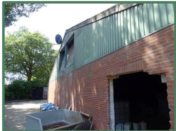
Te slopen stal oostzijde plangebied
