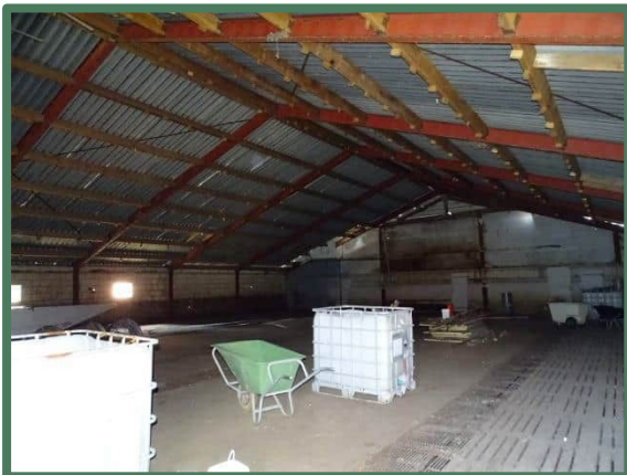
Te slopen stal binnenzijde oostzijde plangebied
