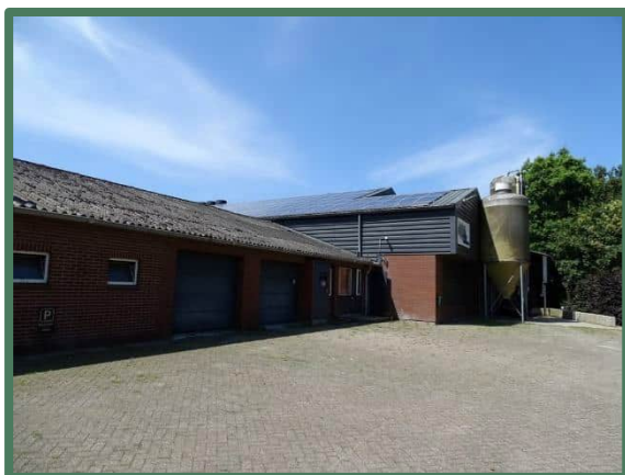
Te slopen stallen oostzijde plangebied
