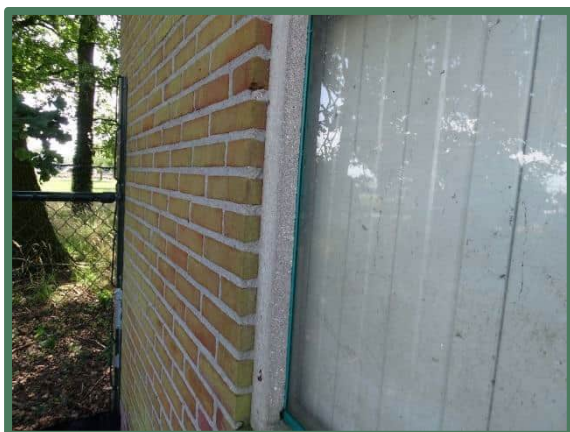
Dichtgemetselde kozijnen
