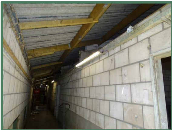
Te slopen stal binnenzijde oostzijde plangebied
