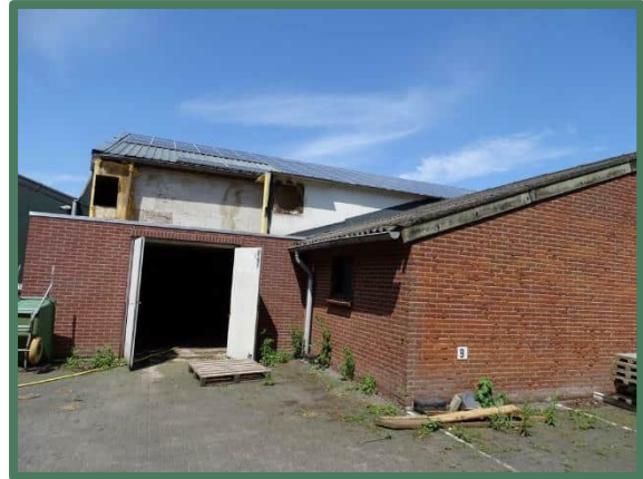
Te slopen stallen en klein gebouwtje oostzijde plangebied
