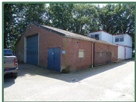
Te slopen stal oostzijde plangebied
