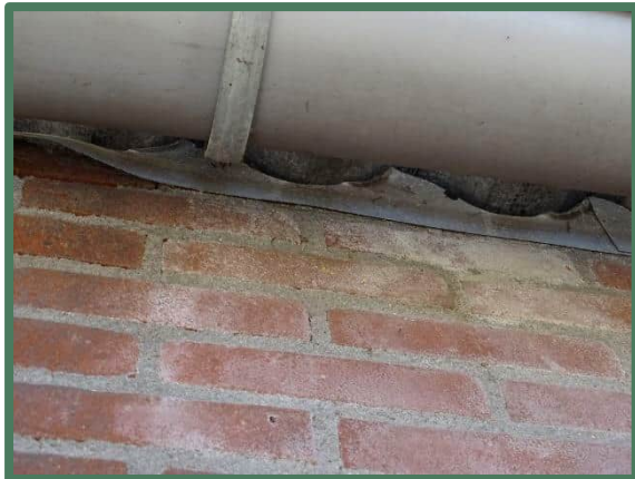
Vogelschroot onder dak
