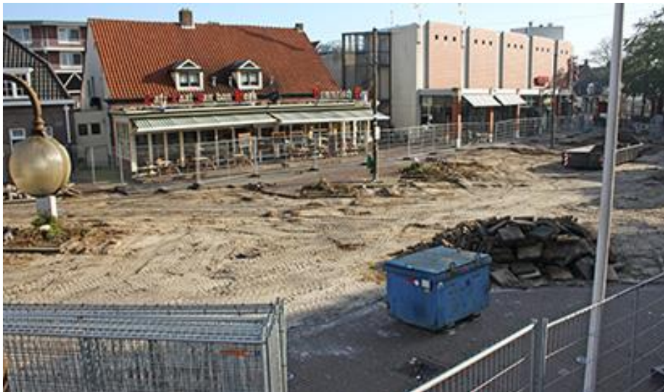
Foto van de werkzaamheden op de Markt.
